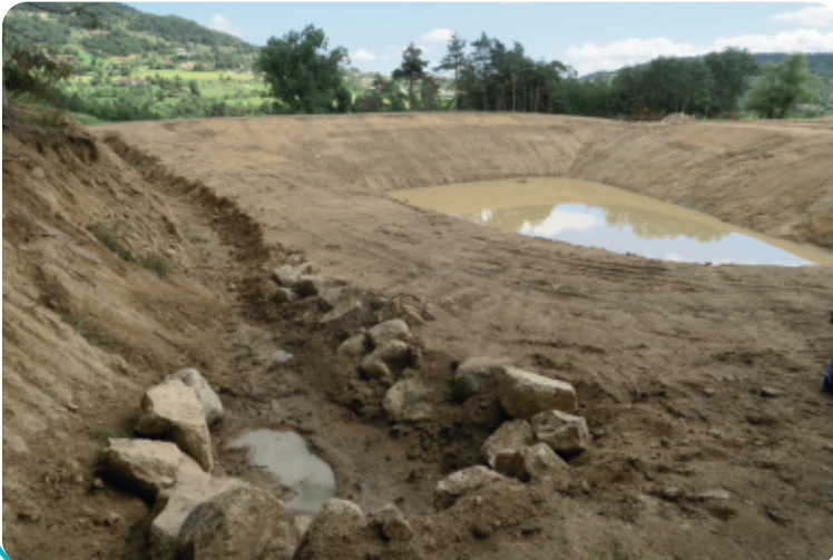
Canal de contournement de la retenue collinaire
